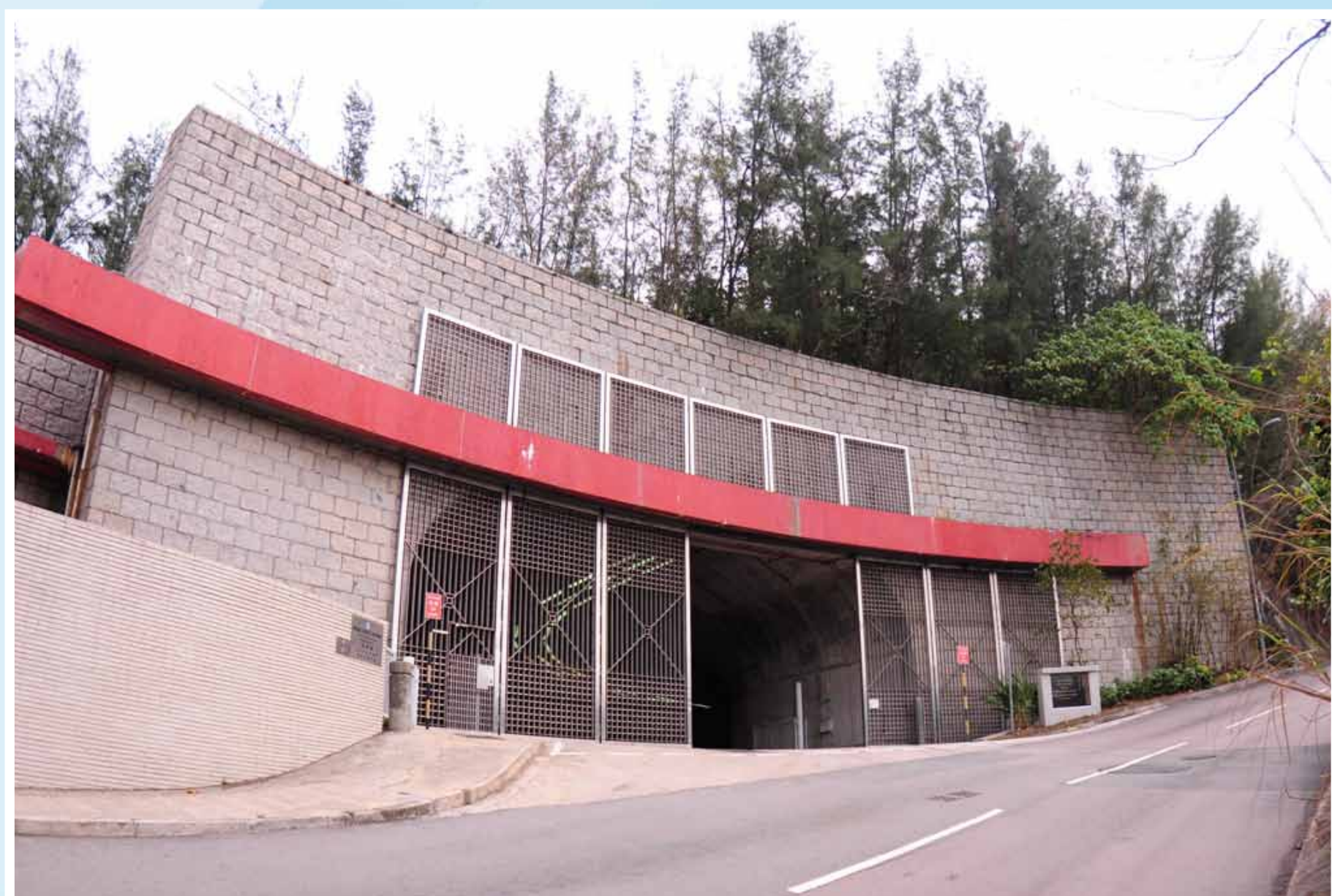
赤柱污水處理廠入口 Stanley STW: Entrance
