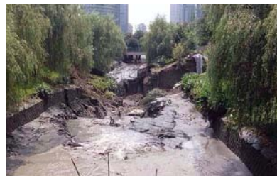
7.31 杭州施工塌陷事故
