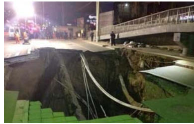
4.4 北京地铁工地塌陷事故
