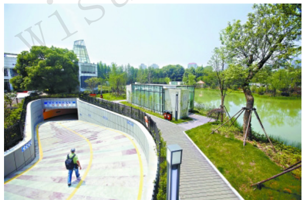
武汉水下停车场出入口实景图
