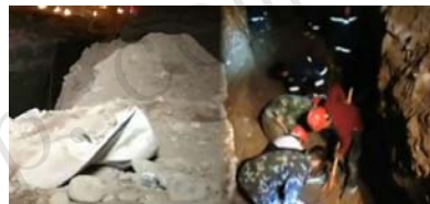
4.28 兰州地铁工地塌方事故
